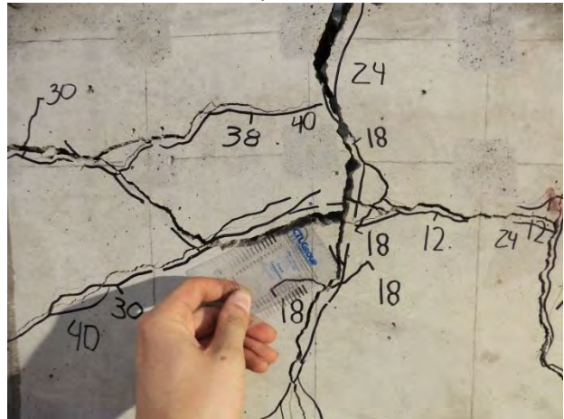
Girder A-6, Load = 46 kip (reload)
