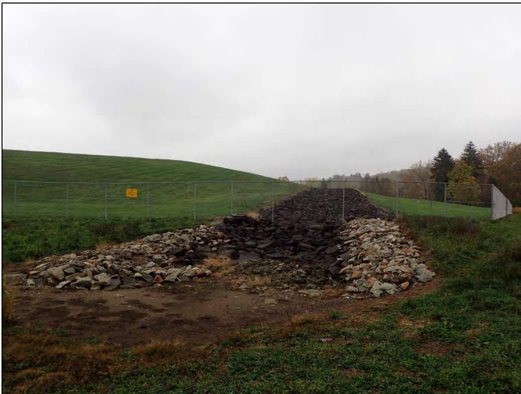
PL-8. Riprap Diversion Ditch Outlet
